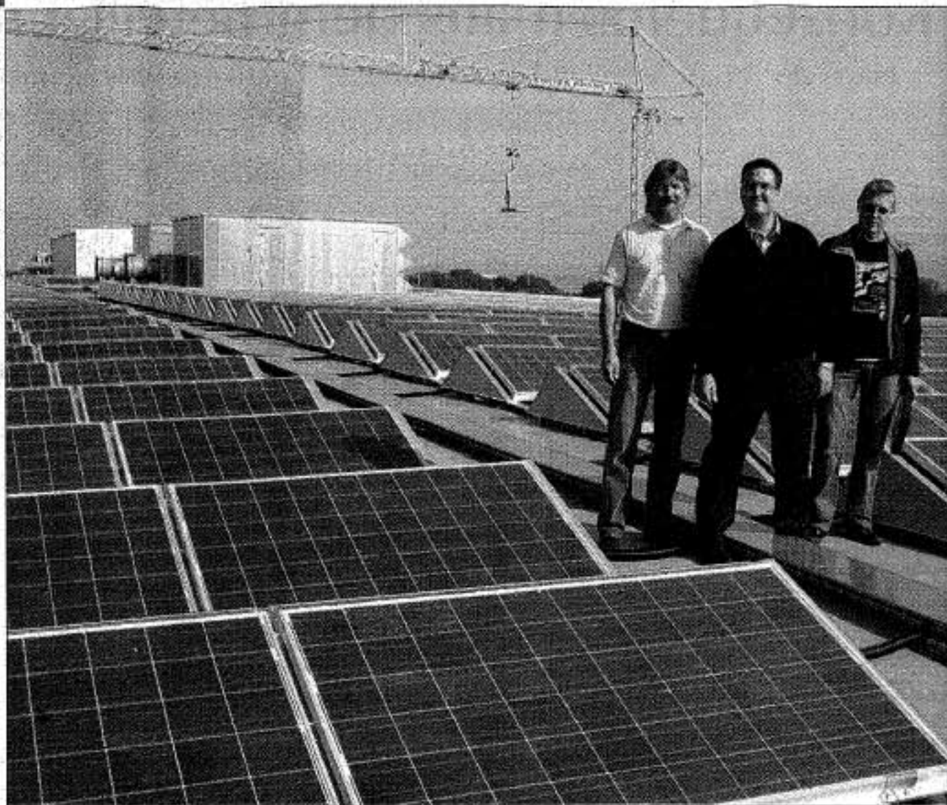
Freuen sich über die große Fotovoltaikanlage auf dem Dach von Möbel Wanninger (v.l.): Haustechniker Achim Dobner, Firmenchef Franz Wanninger und Gerhard Schwarz von der Frankfurter Firma Solarstep.
