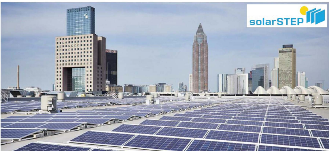
Solarmodule auf Halle 12 (Foto: Messe Frankfurt)
